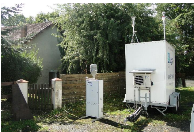
Figure 3 : site B (Source : Lig'Air)
