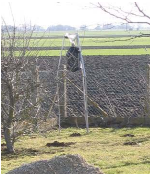
Site N2 – Château d'eau de Marsainvilliers
