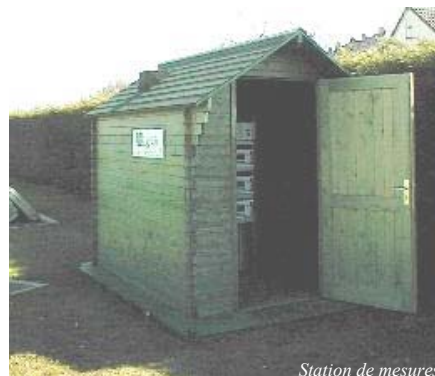
Station de mesures
